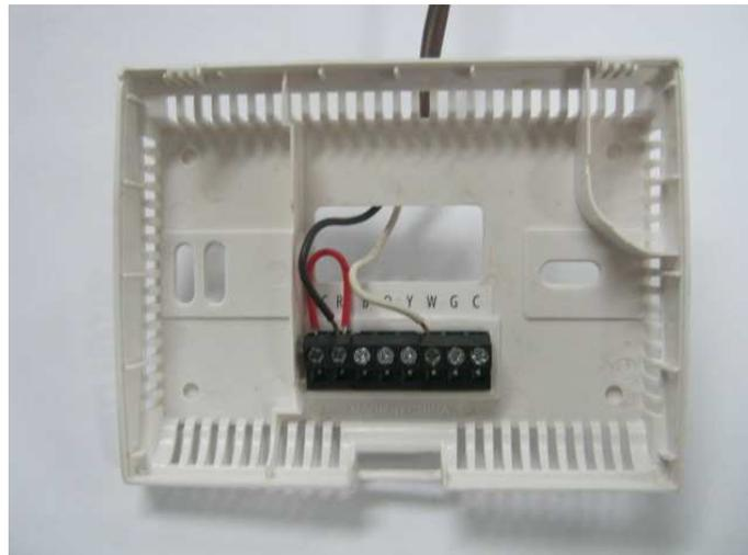
Raccordez un fil sur "RH" et l'autre fil sur "W". Le cavalier rouge peut être laissé en place. Pour de plus amples informations, se référer aux instructions du fabricant.
